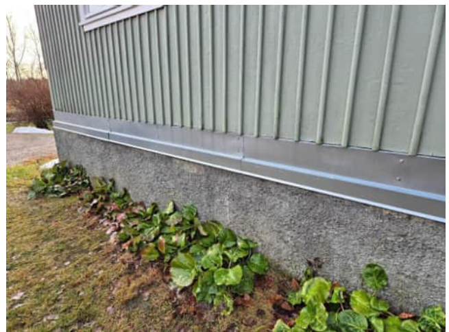
Kuva 9 Sokkelia vasten asennettu kasvipenkki
