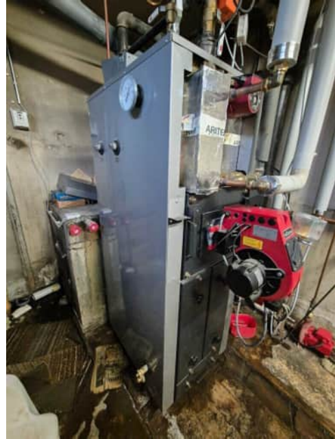
Kuva 72 Lämmityskattila
