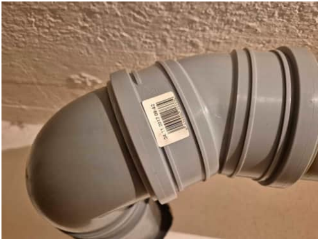
Kuva 81 Uuden puolen viemärit
