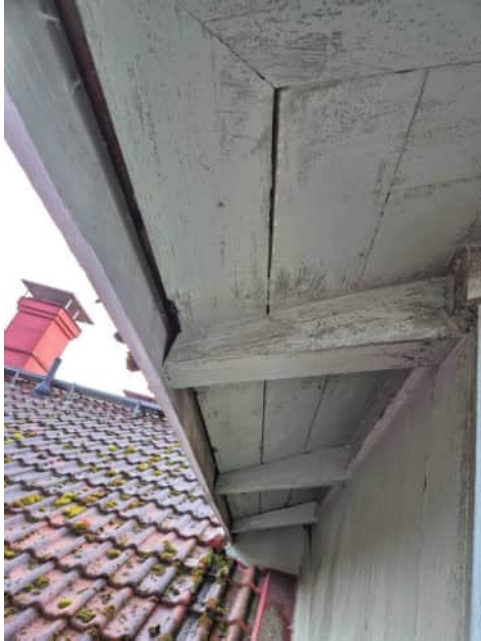
Kuva 43 Vanhan osan räystäs
