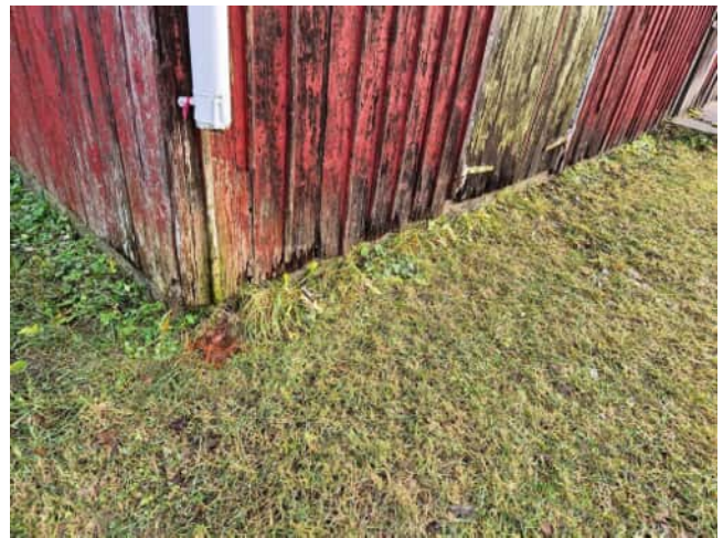
Kuva 11 Sokkelikorkeus on liian matala
