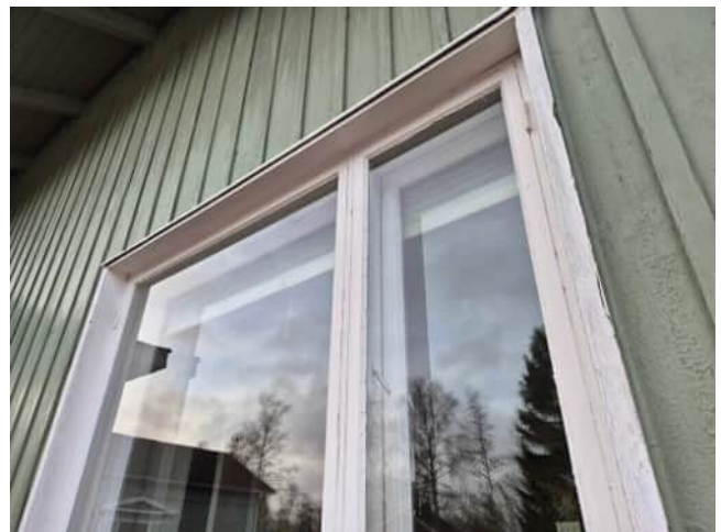
Kuva 33 Laajennusosan ikkuna ulkopuolelta
