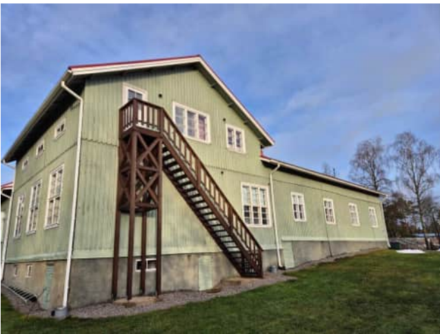
Kuva 17 Vanhan puolen sokkelirakenteet
