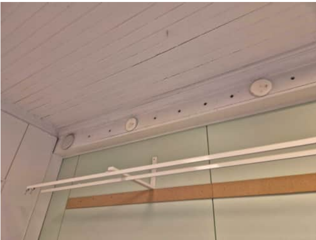
Kuva 78 Vanhan puolen ilmanvaihtokanava
