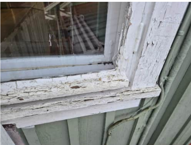
Kuva 32 Vanhan osan ikkuna ulkopuolelta
