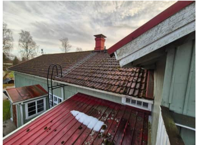
Kuva 40 Vanhan osan katto
