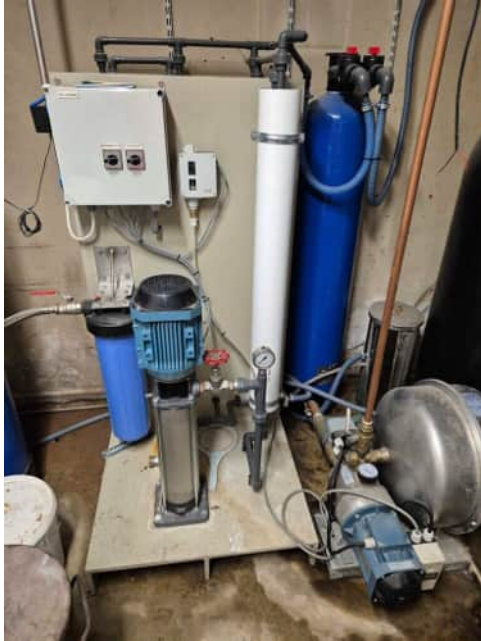
Kuva 79 Paineenkorotuslaitteisto
