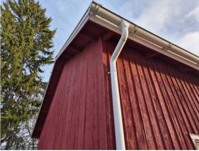
Kuva 12 Räystäs on melko lyhyt
