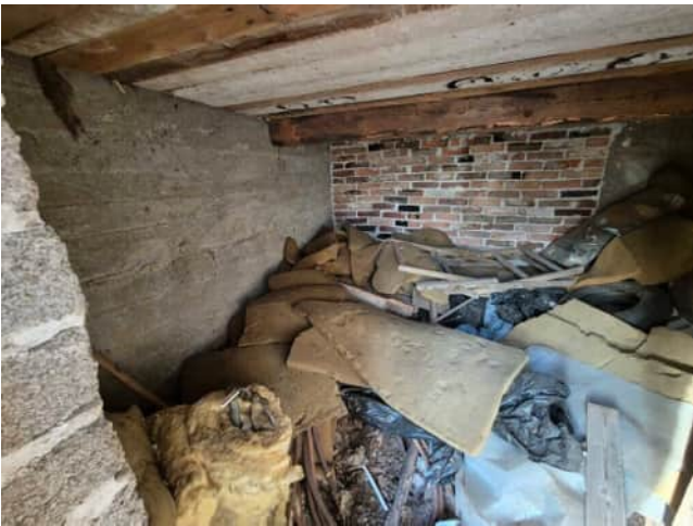
Kuva 19 Vanhan puolen alapohja
