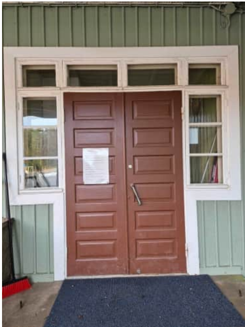
Kuva 36 Vanhan osan umpipuuovet
