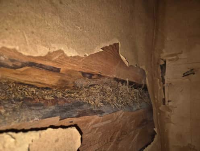
Kuva 23 Liikuntasalista näkyy vanhan osan hirsirunko
