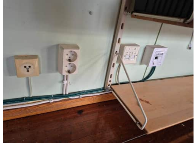
Kuva 90 Lisättyjä pistorasioita
