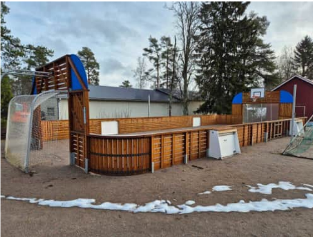
Kuva 3 Aidattu pelialue. Rakennesista pääteltyä rakennettu vuonna 2022 tai sen jälkeen.
