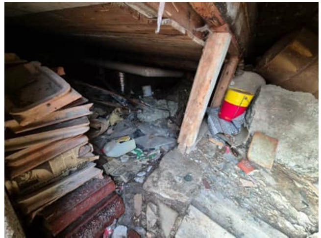
Kuva 20 Vanhan puolen alapohja
