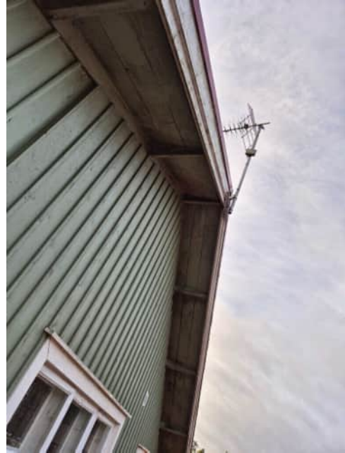
Kuva 44 Vanhan osan räystäs
