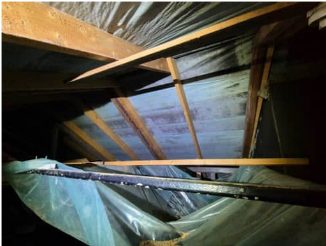
Kuva 45 Vanhan osan vesikatto ullakolta
