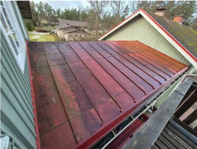
Kuva 39 Vanhan osan katto
