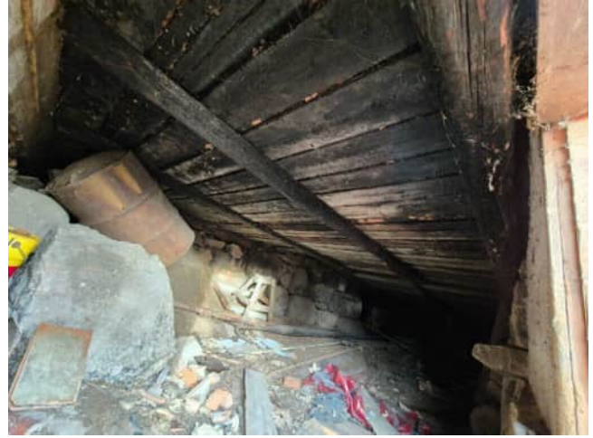
Kuva 22 Yhdessä alustilassa poikkeavan pintaisia pohjalautoja.
