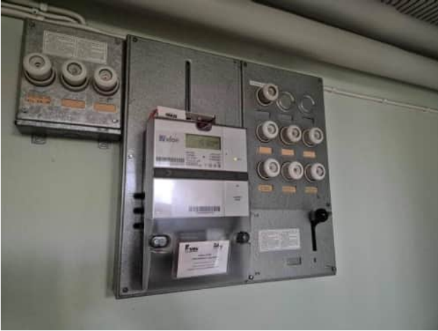
Kuva 85 Laajennusosan ryhmäkeskus
