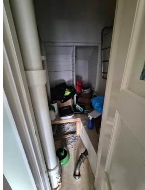
Kuva 80 Vanhan puolen viemärit
