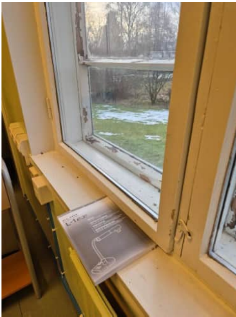
Kuva 30 Uusittu sisäpuolen puitteen lasitus
