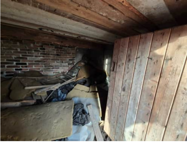
Kuva 21 Pääasiassa alapohjan rakenteet olivat terveinä oloisia.
